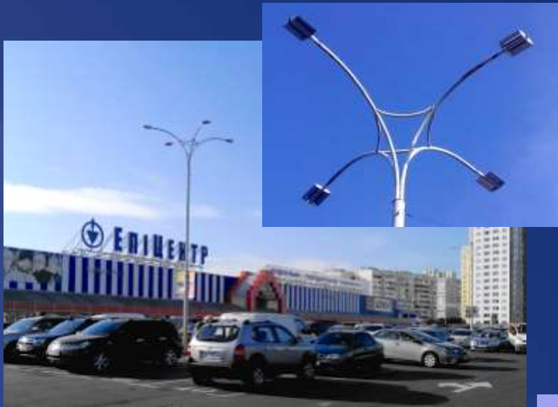
Світильники CORSAR B 100 Освітлення паркування. Гіпермаркет «ЕПІЦЕНТР» м. Київ вул. Григоренко.
